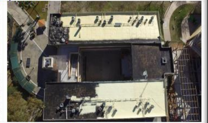
Instalación de recubrimiento Elastomérico
