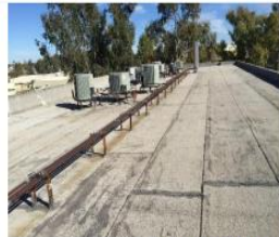
Preparación y limpieza total de techos
