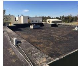
Preparación y limpieza total de techos
