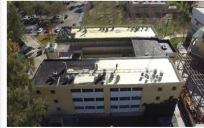
Instalación de recubrimiento Elastomérico
